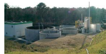
Station de traitement de Lixiviats
